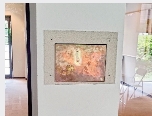
写真1 柱の中の銅箱
