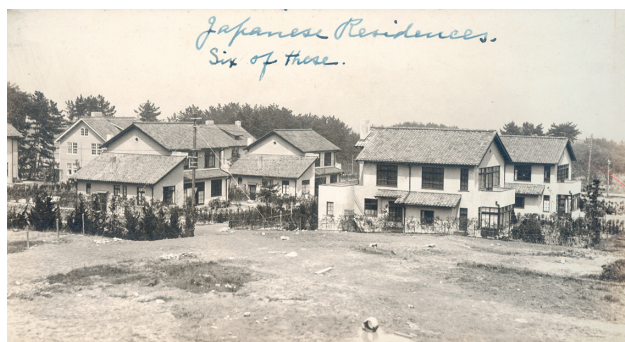
旧日本人住宅（『神学部アルバム』1930 年頃より）
